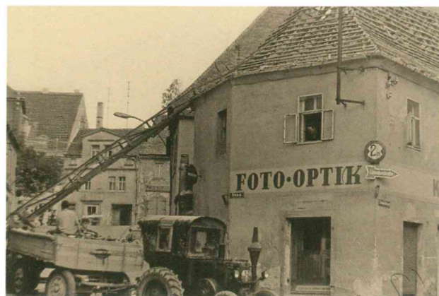
Beginn der Abrissarbeiten sämtlicher Gebäude des „Dreieck“ in Querfurt, hier Blick vom Matzplatz
